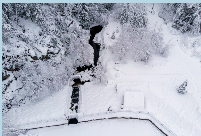
Demningen sett ovenfra, fra sør. Foto: Ø. Søbye/Photographica
