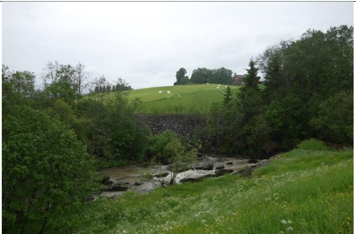
Erosjonssikring med steinvold ved Gjermåa. Nyetablert beite i erosjonsutsatt, hellende terreng i dråg i bakgrunnen (inngjerdet) Foto: A-G. B. Blankenberg.
