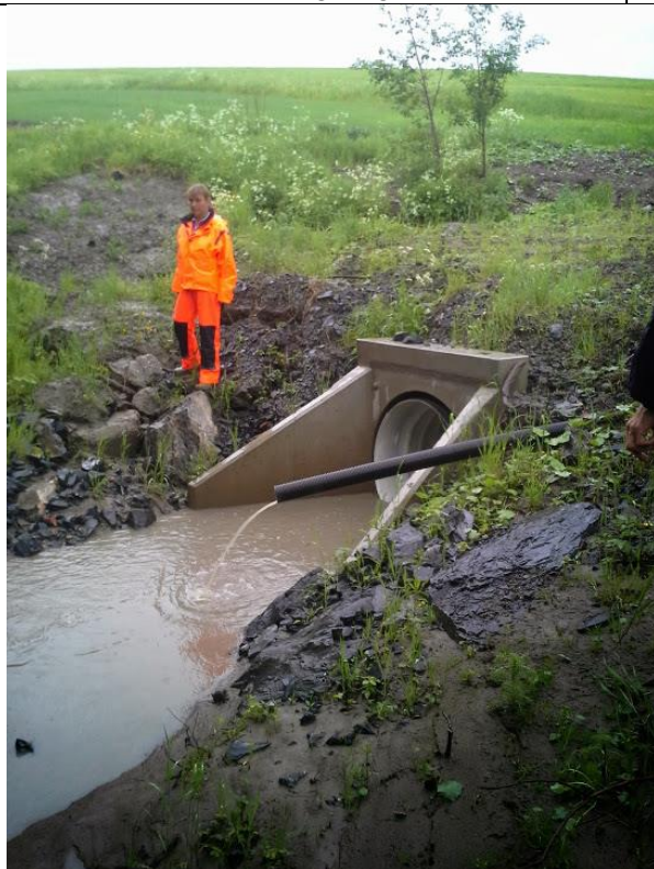
Sikring av innløp, Vangsbekken. Foto: Romerike Landbruksrådgiving
