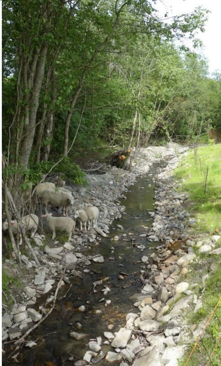
Steinsetting av bekkekant. Fra grupperåd- vandring i Nannestad, 17.juni 2014. Foto: A- G. B. Blankenberg.
