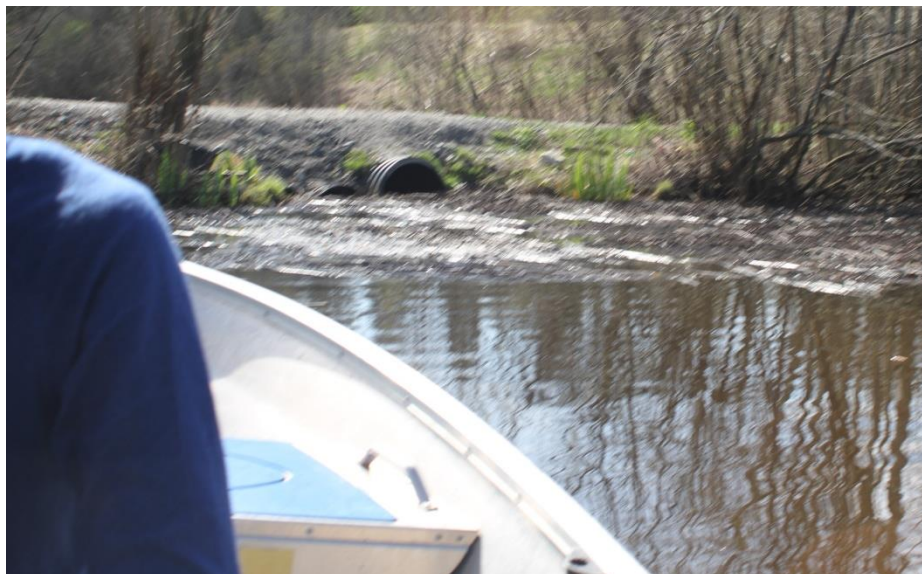
Figur 4: Kulvertene mellom de to delene av Stilla. Det er en opphoping av dødt siv og andre planter, som reduserer effekten av kulvertene.
