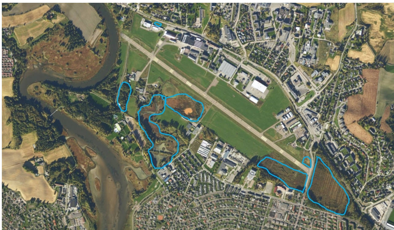
Figur 11 I bildet over er vann- og myrforekomster som er tett tilknyttet Kjeller flyplass, tegnet inn. Dette er områder der man om mulig bør unngå skader ifm anleggsarbeid. Vann- og myrforekomstene kan være viktige med tanke på håndtering av flomvann.
