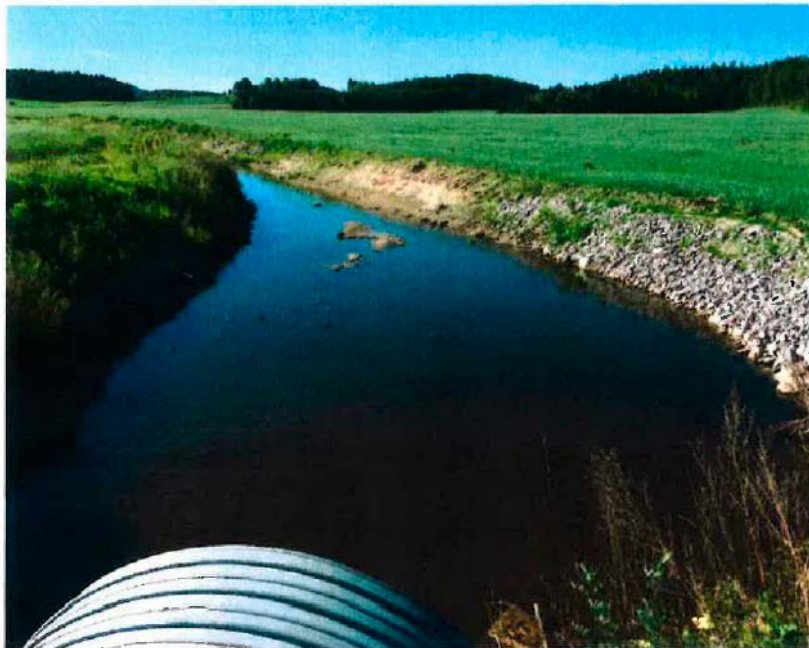
Figur 3 Øverste del, hvor elveløpet var rettet noe ut og elvesiden var steinsatt for å unngå erosjon.
