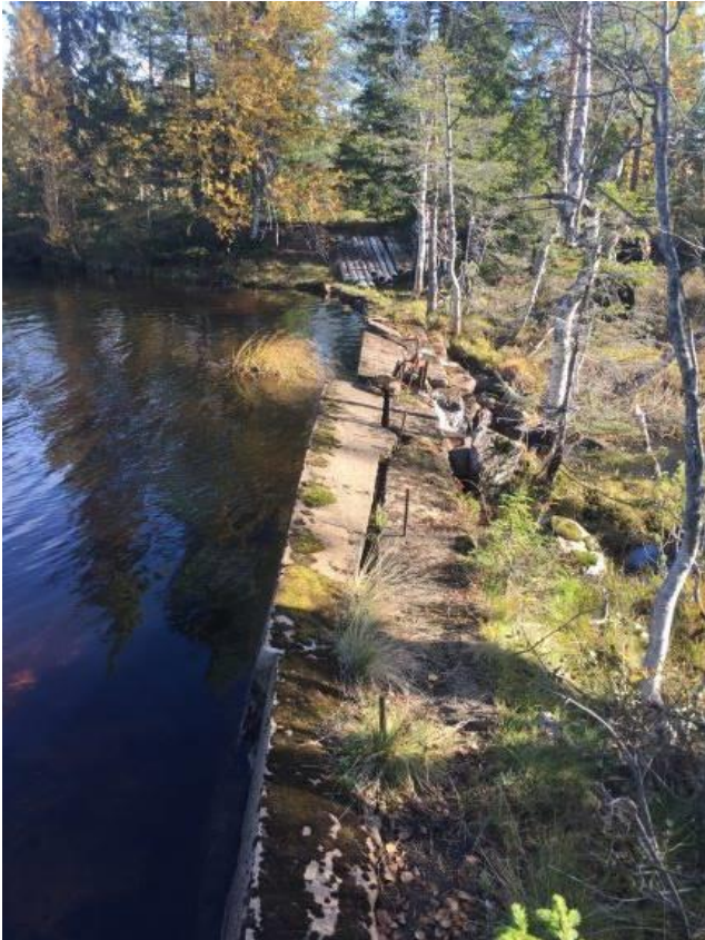
Dam sett mot øst (v) og vest (h). Deler av dammen har sklidd ut.
