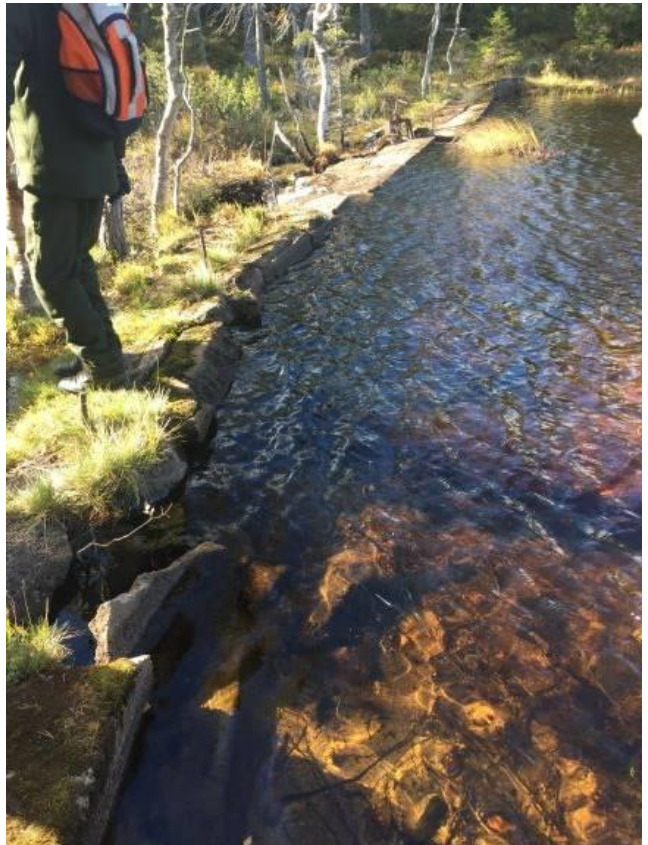
Dam sett mot øst (v) og vest (h). Deler av dammen har sklidd ut.
