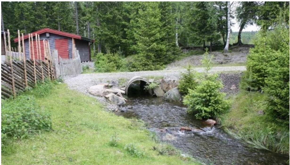
Figur 18. Kulvert med naturlig bunn i Djupøyungsbekken. Dammen vises som horisontal linje over veien. Hyttetunet til Øyungshytta vises til venstre i bildet. Foto: Wold m.fl. 2019.
