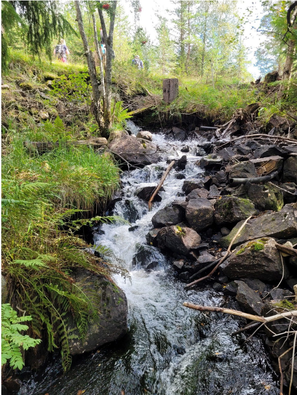
Figur 20. Veikulvert (øverst i bildet) under Øyungsvegen og bratt fall videre nedstrøms i Djupøyungsbekken, august 2024. Merk de løse steinmassene og mye "hvitt vann". Foto: NRAS, Odin Kirkemoen.
