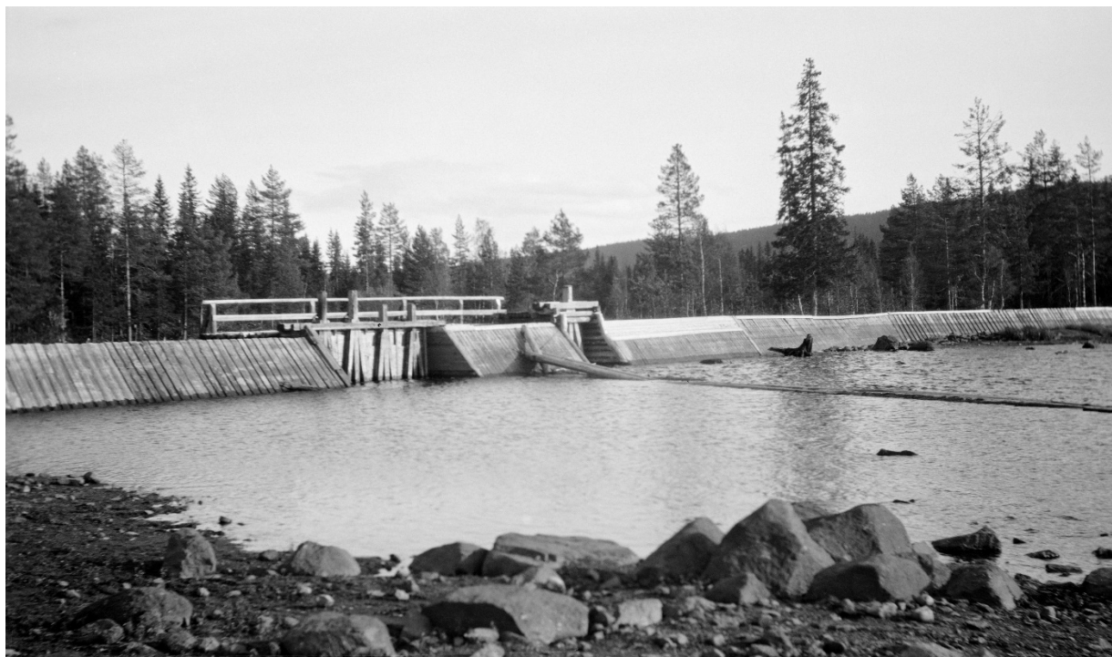
Figur 11. Lukedam av tømmer, etablert ved utløp av Stråtjernet og fotografert i 1925. Kilde: Digitalt Museum.
