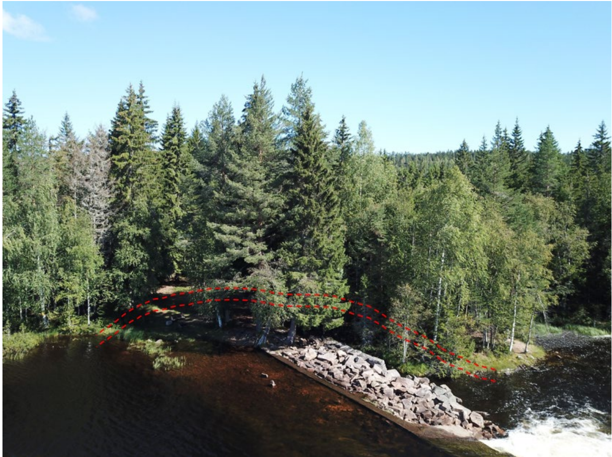
Figur 25. Dronefoto av nordsiden av demningen ved Stråtjern. Omløpet er skissert med rødstiplede linjer. Innløp i omløpet planlegges i viken like oppstrøms demningen. Foto: Skred AS, Lars Staver Eid.
