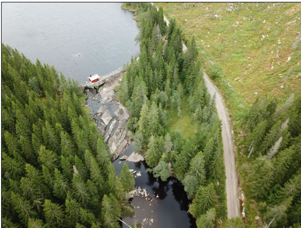
Figur 10. Vannspeilet til innsjøen Vrangen øverst på bildet, med dammen og damhytta. Vannspeilet nederst på bildet er Lauvtangen.
