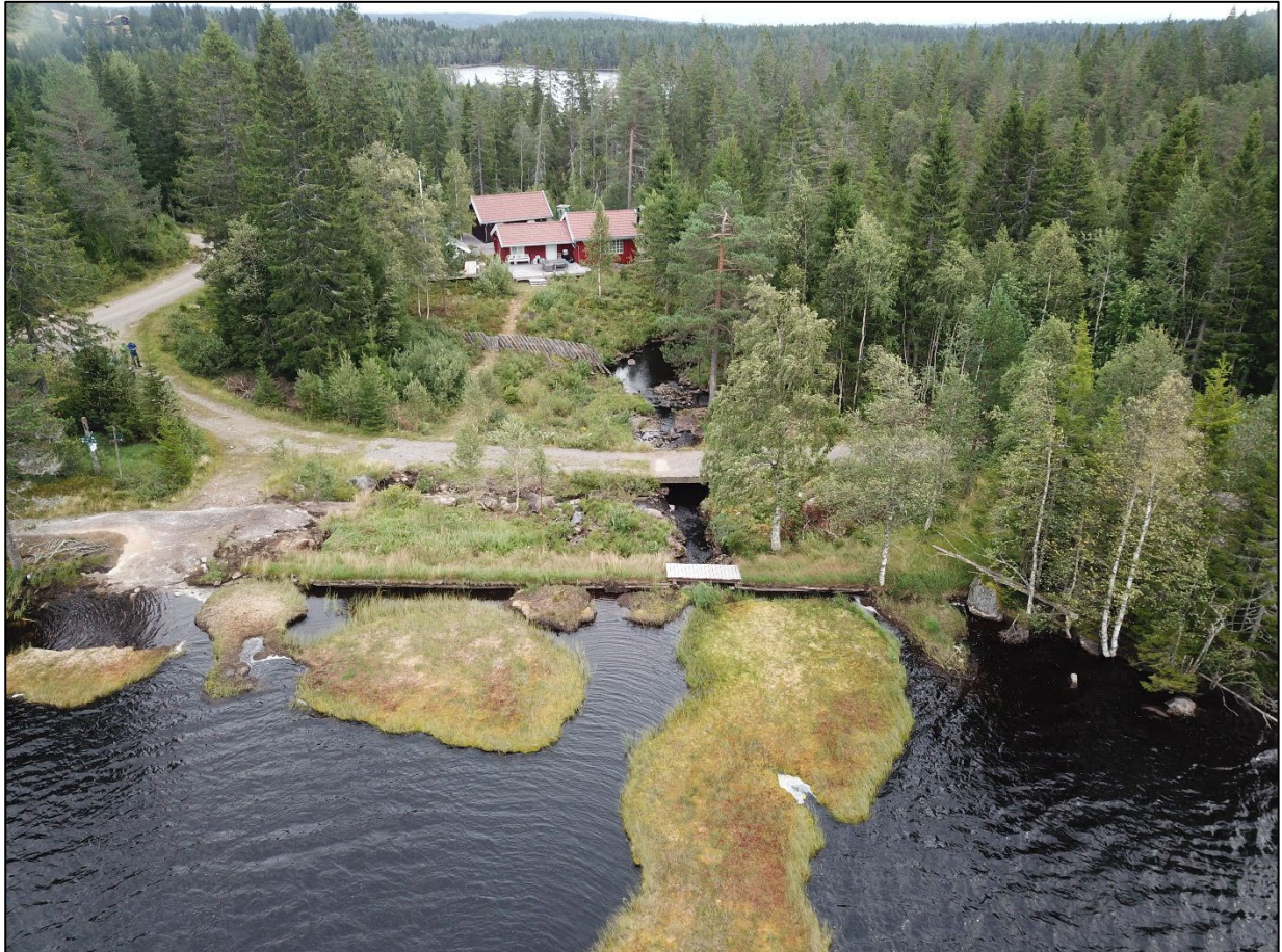
Figur 12. Dammen ved Lauvtangen vist fra luften. Bekken vises der den renner under skogsbilveien og ned mot Damsortungen (vannspeilet som vises øverst på bildet). Bildet er tatt mot øst. Merk berg i dagen til venstre (nord) for damkroppen.
