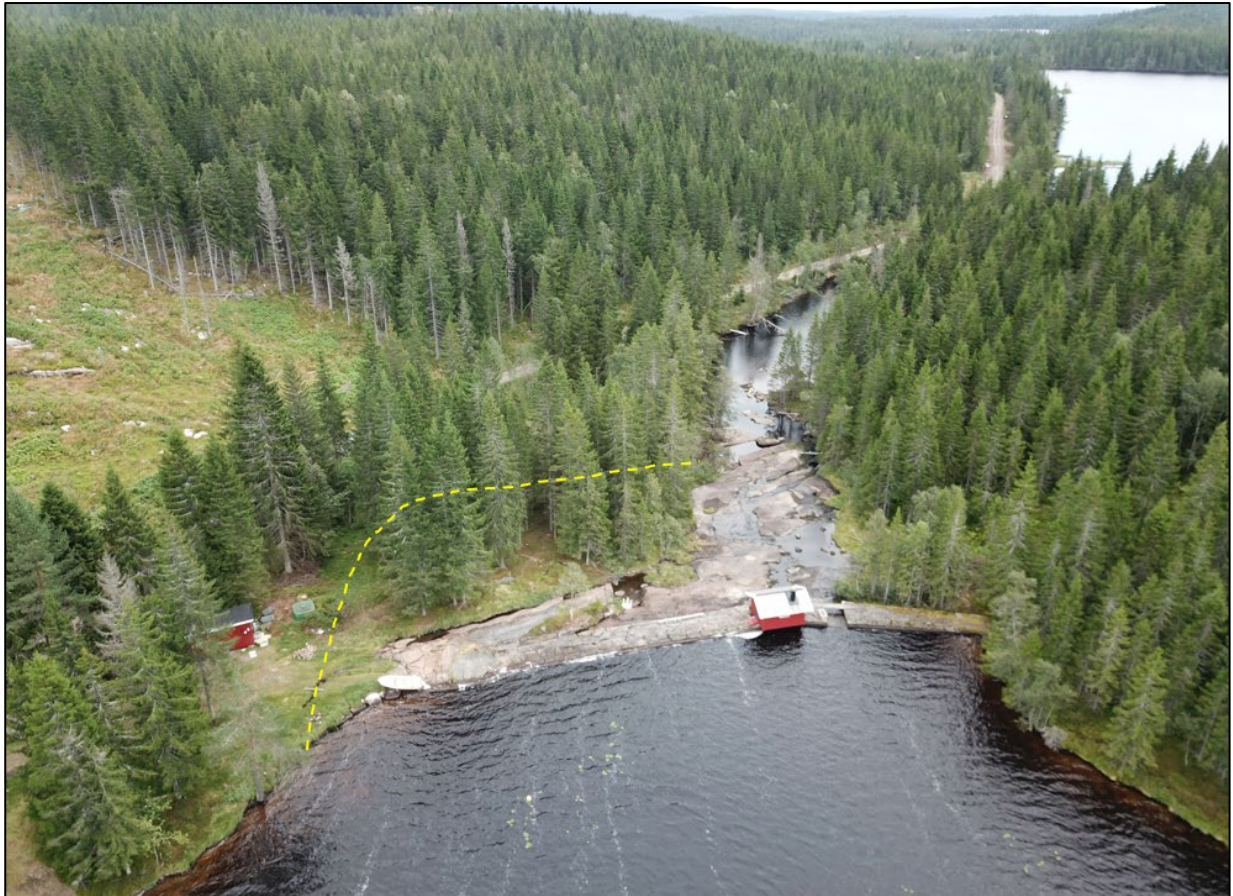
Figur 15. Demningen ved Vrangen, ved utløpet ned mot Lauvtangen. Vrangen vises i nedre del av bildet, og Lauvtangen vises øverst til høyre i bildet. Skissert trasé for omløp på nordsiden av demningen vises som gulstiplet linje. Bildet er tatt mot øst..
